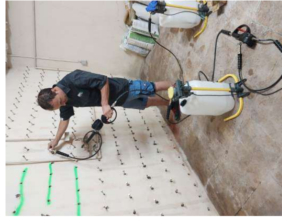
Die Injektionslanzen werden schachbrettartig an der betroffenen Wand angebracht.
