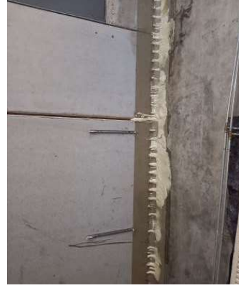
Erstellung einer Dichtkehle mit anschließender Verpressung.
