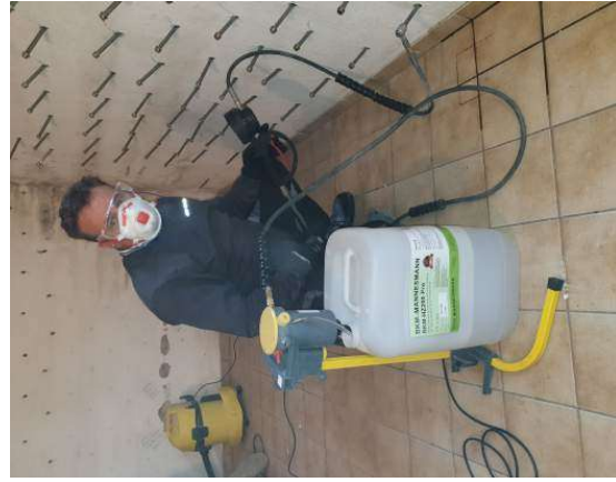
Die Injektionslanzen werden schachbrettartig an der betroffenen Wand angebracht.
